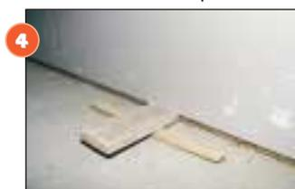
Mise en place des cales de sécurité durant le temps de prise du mortier.
