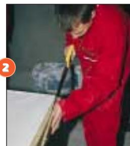
Ajustement du joint thermique par découpe à la hauteur sous plafond.
