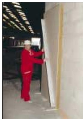
Selon le DTU 25.42, le doublage est posé à l'avancement contre le mur à isoler buté en tête sous le plafond, soit directement, soit par l'intermédiaire de cales disposées sur le sol. Celles-ci maintiennent en place le complexe le temps de la prise du mortier adhésif et permettent de réaliser correctement la jonction avec le plafond. L'espace restant entre le complexe et le sol
