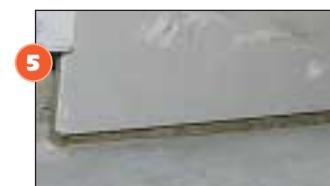
Après séchage et une fois la cale ôtée, la jonction thermique est assurée
