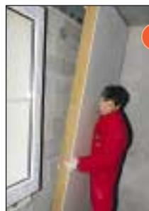
Mise en place du doublage reposant sur le joint thermique.
